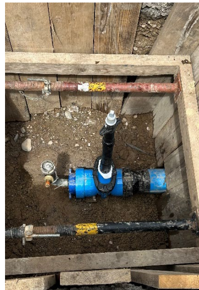
Druckprobe eine Teilstrangs
